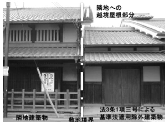
写真1 基準法適用除外による隣地越境屋根の維持の事例
