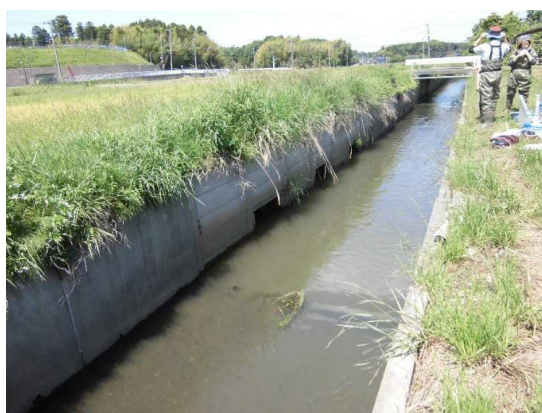
写真3 併設水路の対象区間
