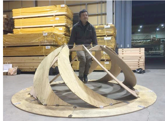
図9 8角形ドーム、合板製 D=2.1m, H=1.1m
