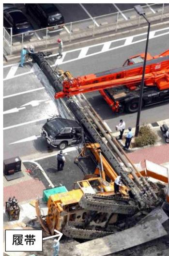
写真1 くい打機の転倒災害
