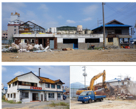
図 6 水産施設など（敵散家屋）の取壊し（2013年）
