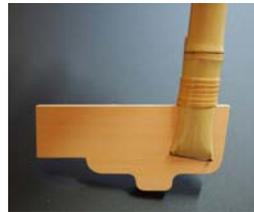
B: 下部の四方枠と主構造の竹の接合
