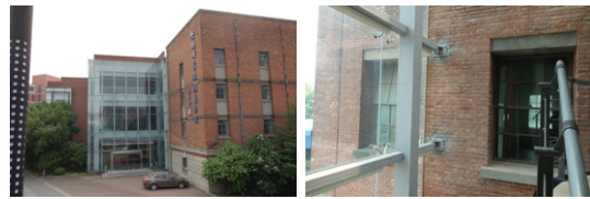
図13 無錫民族商工業博物館 外観 図14 同左 新設部分との接合部
