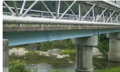
図7 橋梁補修工事での実証試験
