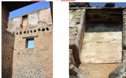
VII.2.18 : Domus C. Vibi の上階 latrina
