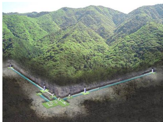
図2. KAGRA (3km のアーム長を持つ低温・地下重力波検出器) のイラスト。
