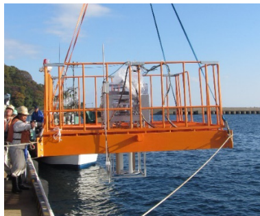
図5 浮体式水車発電システム全体の様子
