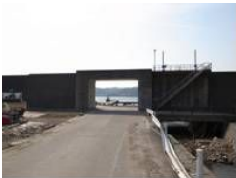
写真: 集落と海とは要塞壁のような巨大な防潮堤で隔てられている: 宮古市
