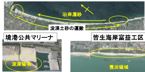
図-2 皆生海岸におけるサンドリサイクル
