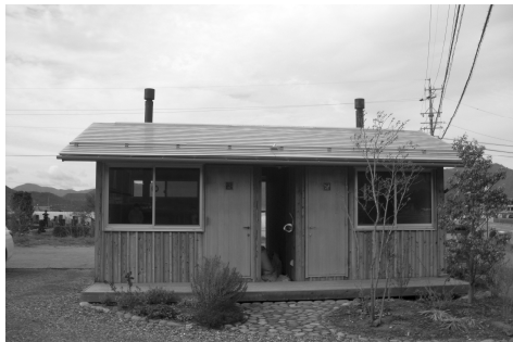
図 3: 実験棟の外観
