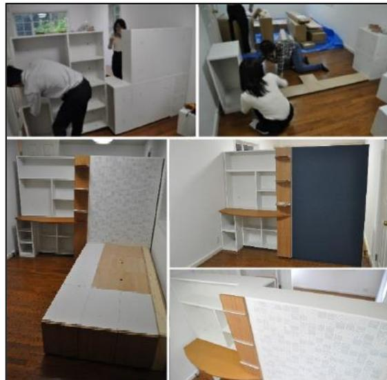
図8 再構成による複合インフィルの実大試作
