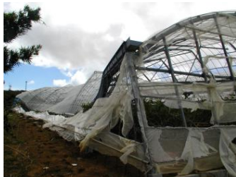
図 1 鉄骨ハウスの強風被害例
