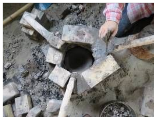
写真 1 送付管の設置状況
