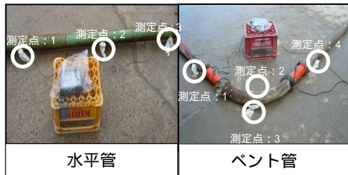
写真-1 水平管とベント管の加速度センサーの取り付け状況
