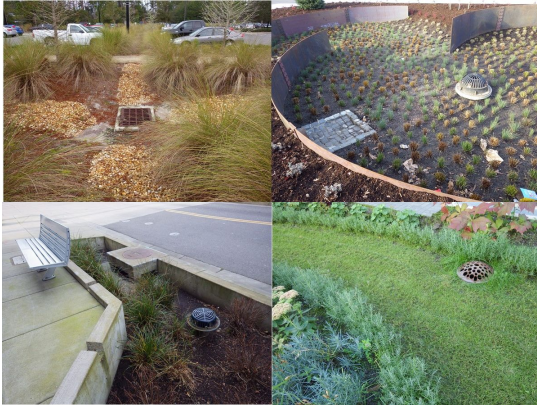
図 4 レインガーデンと下水管渠の接続状況
