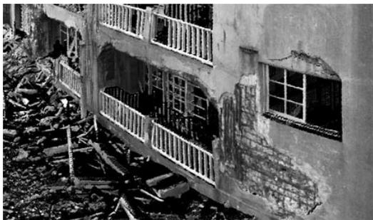
図1. 構造物劣化状況の3D計測結果の可視化例
