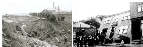
図7 英国ノースウィッチウッドランズの製塩跡地における地盤沈下の状況と倒壊した建物
